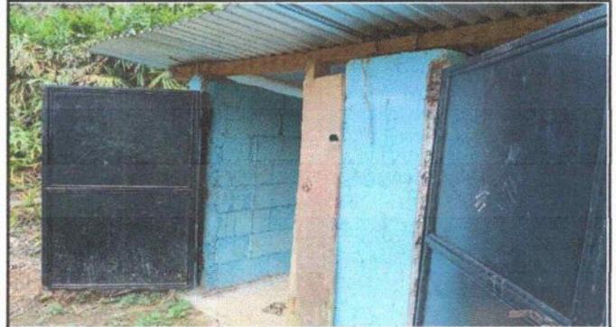
Foto 2: Baños del establecimiento con techo en mal estado y que es necesaria la sustitución de laminas y soporte.
