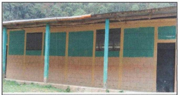
Foto 6: Vista de establecimiento donde se observa la necesidad de colocar canales y bajadas de agua pluvial de forma formal, ya que por el momento solo se ha improvisado con tubos las bajadas de agua.
